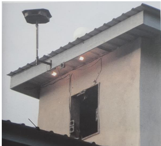
Hình 1. Cửa chim vào nhà mở ở phòng lượn với loa nóc và loa cửa
